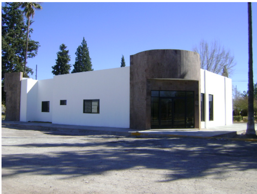
Figura V.14. Vista de Edificio del C.E. Delicias.
