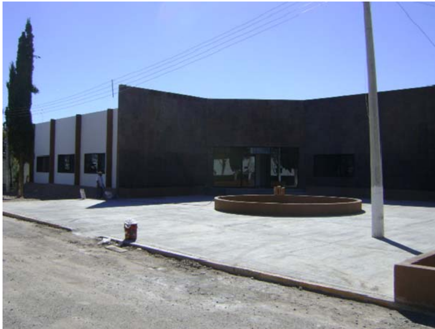
Figura V.15. Vista de Edificio del C.E. Delicias
