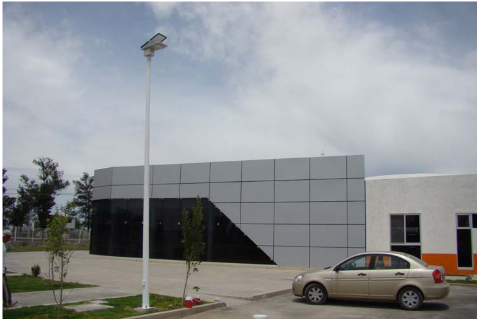
Figura V.17. Vista de Edificio del CIR- Centro.
