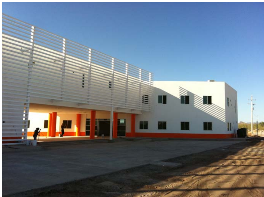
Figura V.16. Vista de Edificio del C.E. Costa de Hermosillo.
